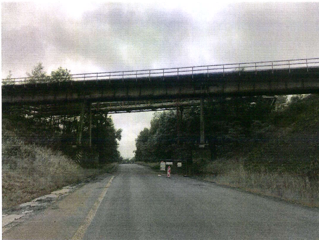
Železniční most vlečka PKP Cargo International, a.s.
